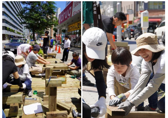
「大きなベンチ②」施工風景 (6月17日)
